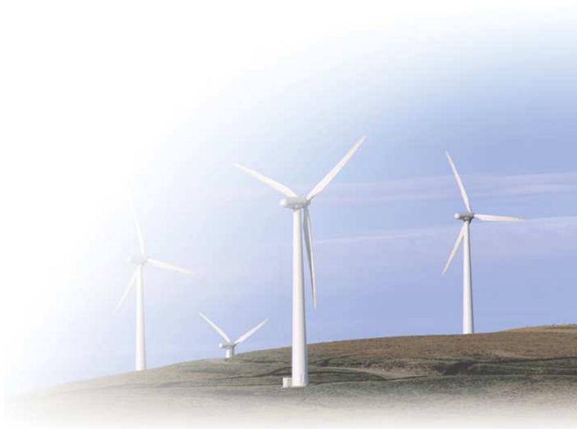
Eoliene cu ax orizontal cu rotorul de tip elice
